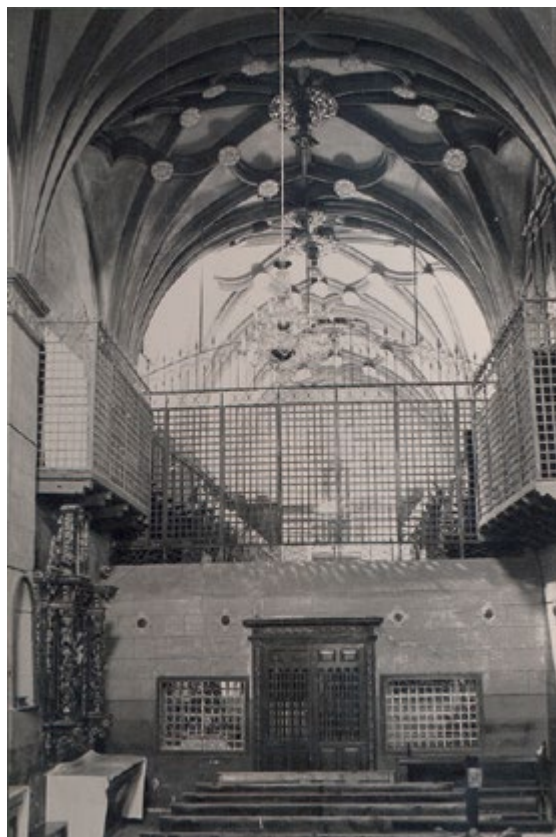
Fotografía del interior de la nave de la iglesia del monasterio de Tulebras, c. 1960 [izda.].
